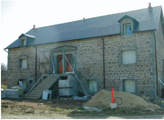
Maison en cours de rénovation (Le Compas)
